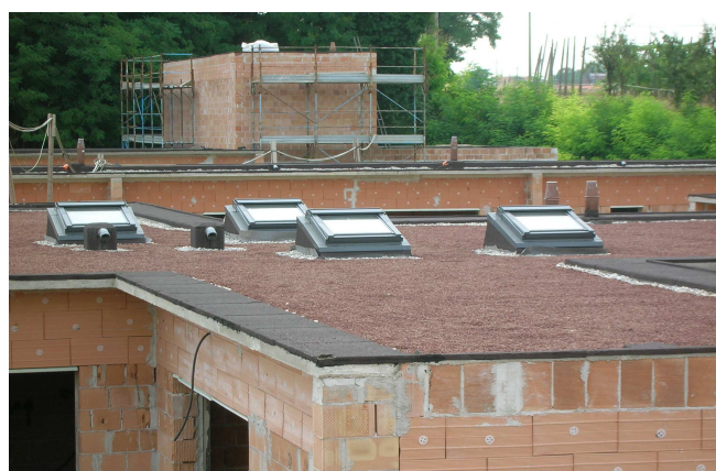
Cantiere in fase di realizzazione con finestre per tetti piani con basamento VELUX
