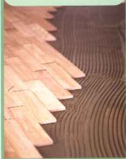
Posa del parquet con LIGNOBOND
