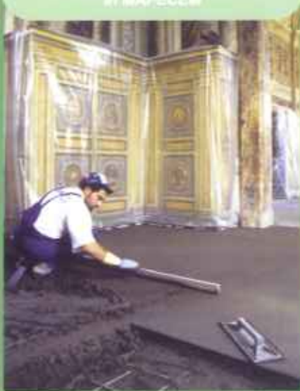
Staggettatura del massetto in MAPECEM
