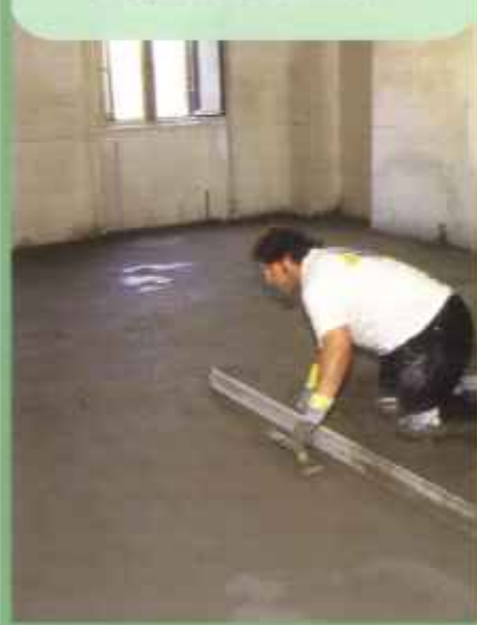
Steggiatura del massetto
