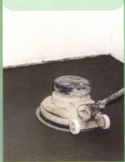
Finitura con disco d'acciaio
