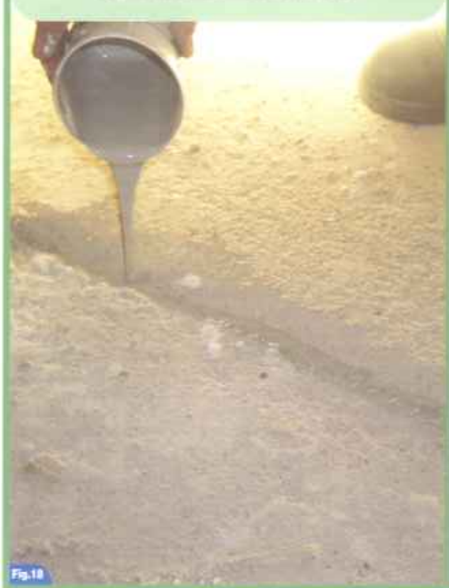
Sigillatura delle lesioni con Eporip
