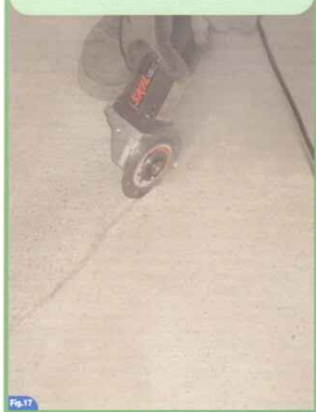
Apertura delle fessurazioni con flessibile
