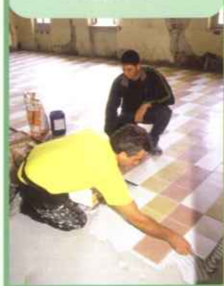
Posa delle piastrelle
