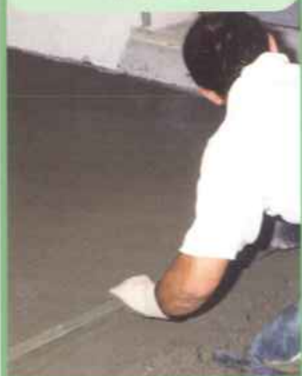
Staglieratura del massetto in TOPCEM
