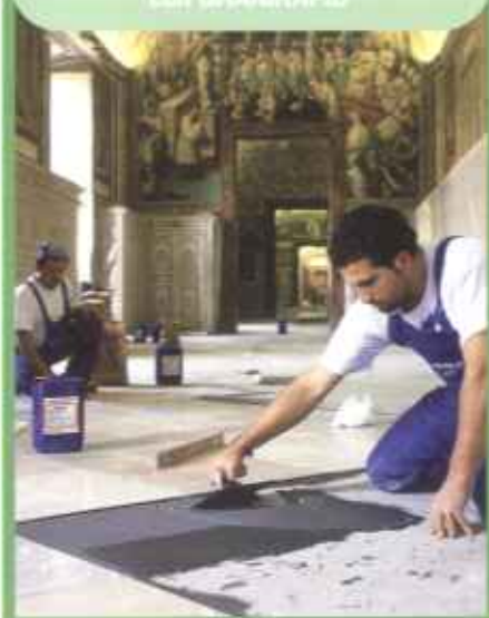
Posa delle piastrelle in Gres porcellanato con GRANRAPID
