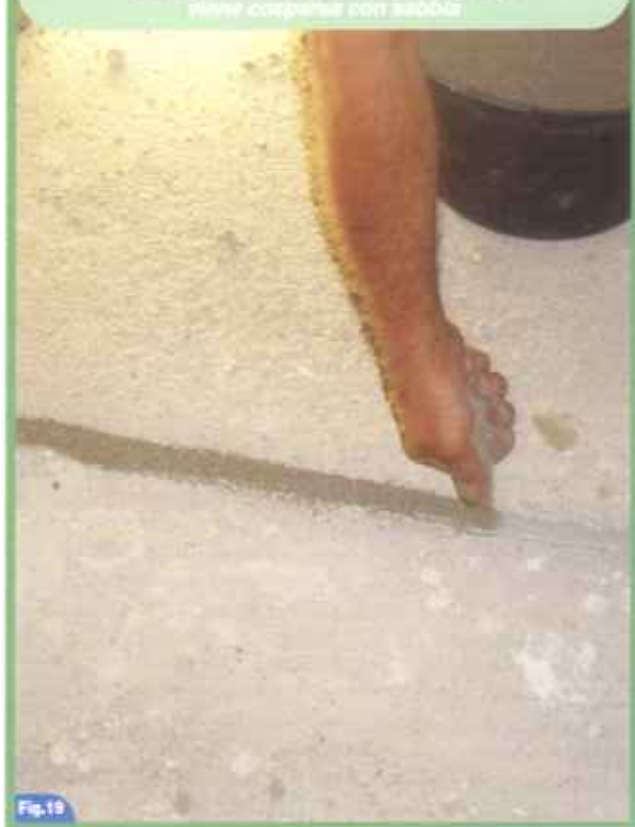
La superficie ancora fresca di Eporip viene coperta con sabbia
